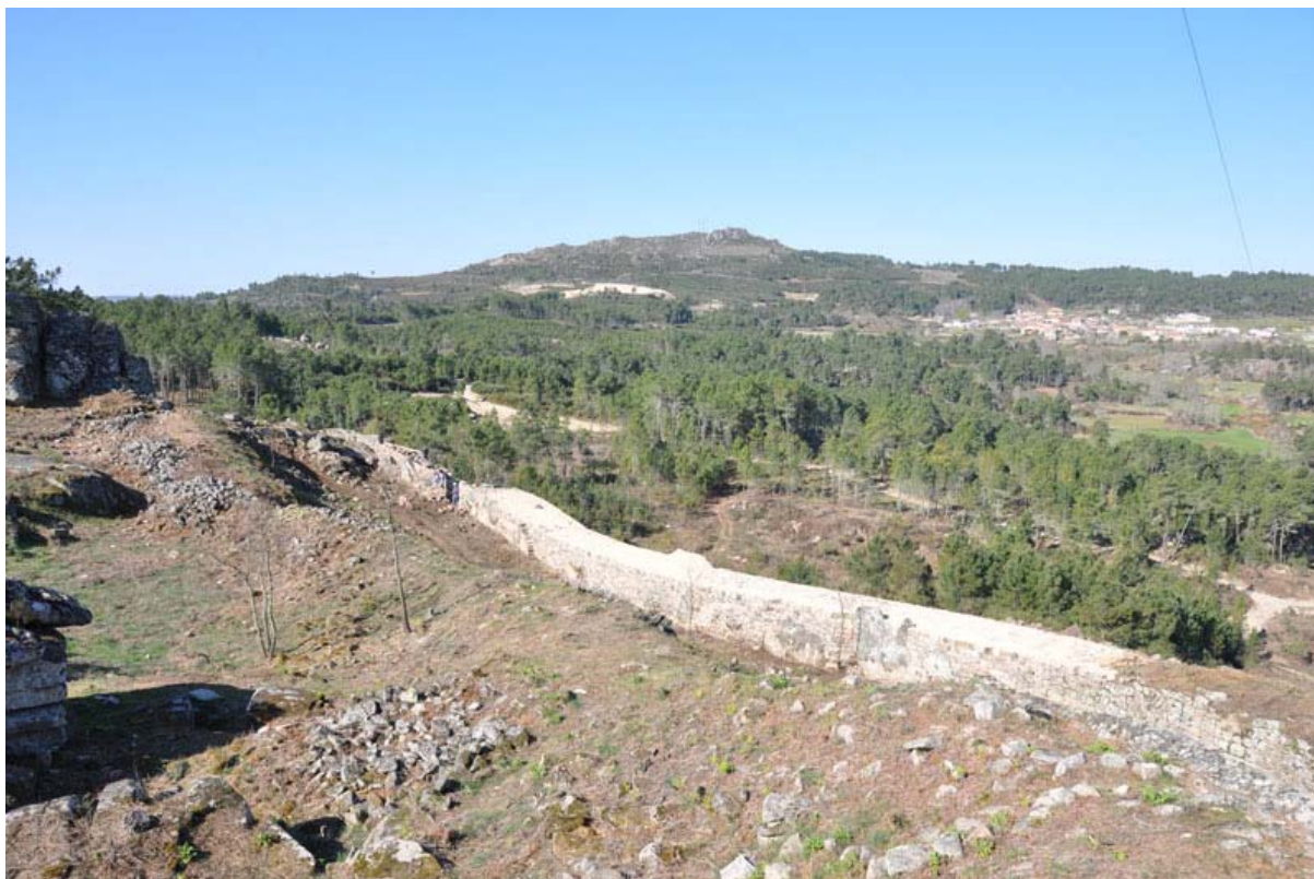
Castro de S. Marcos – Trabalhos finais de recuperação da 2ª linha de muralha
