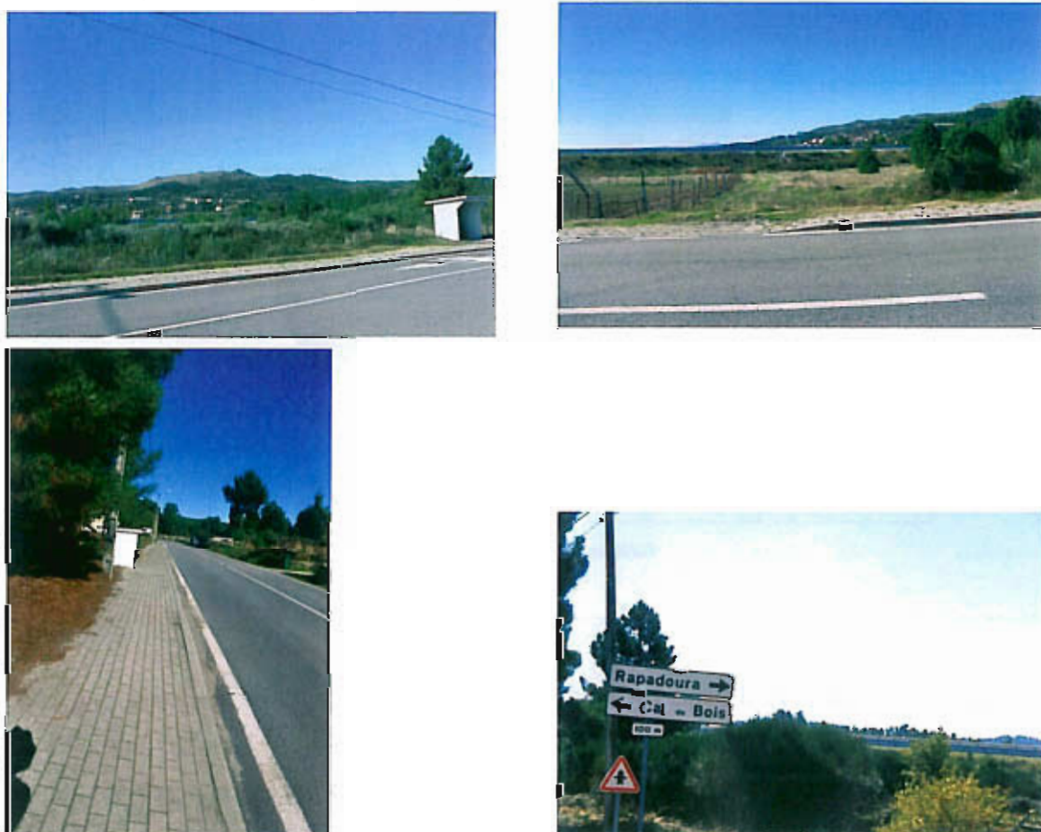
Figura 12 - Duas Imagens da EN 212 que mostram o passeio e a proximidade das duas vias
