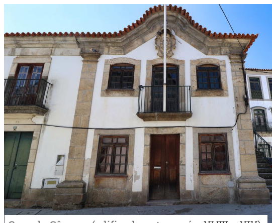
Casa da Câmara (edificada entre o séc. XVIII e XIX)
